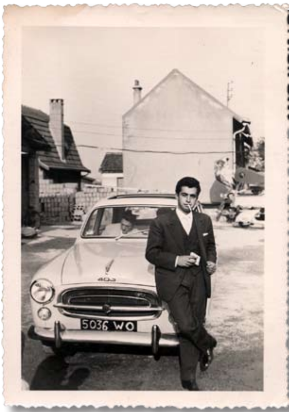
Francia, 1958. Marino Serra vicino alle baracche dove alloggiava con 25 operai sammarinesi.
