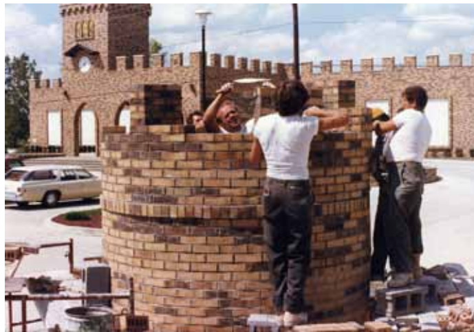
Detroit (Troy) 1975. Angelo Moretti con dei colleghi sammarinesi al lavoro di costruzione del San Marino Social Club.
